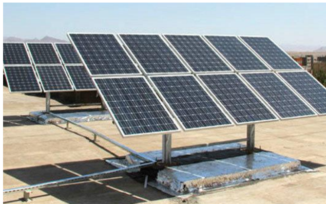
سازه سقف خانه
